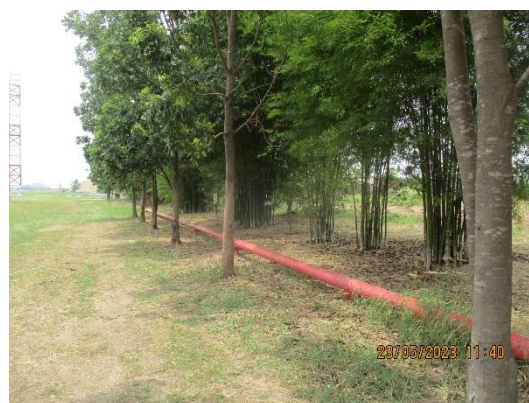
รูปที่ 10 ระบบป้องกันอัคคีภัยรอบลานกองขนถ่าย
