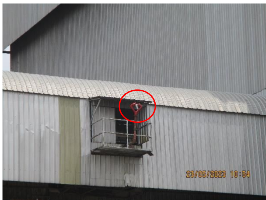
รูปที่ 5 ระบบฉีดพรมน้ำกองขานอ้อย
