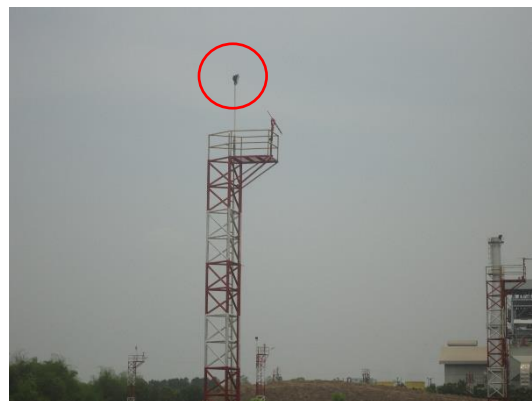
รูปที่ 5 ระบบฉีดพรมน้ำกองขานอ้อย
